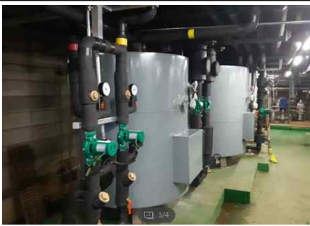
급탕탱크 신규 설치
