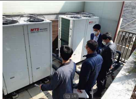
공기열 히트펌프 교체
