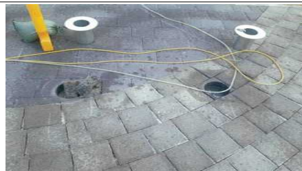
아현문화건강센터 외부 차량진입 방지용 U형 블라드 설치
